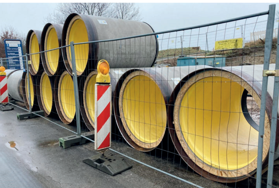
Типовой склад труб Perfect Pipe на строительной площадке (Харен, Германия). В 2021 году здесь впервые в Германии была выполнена проходка с укладкой труб для микротоннелирования Perfect Pipe DN 1200
